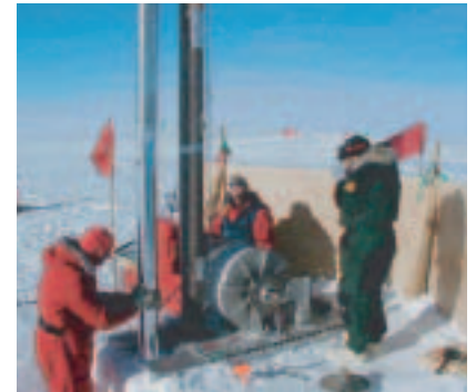
Seismische GSN-Station QSPA am Südpol, Antarktis. Der Bau dieser Station erforderte das Anbringen von Bohrlöchern im Eis mit einer Tiefe von ungefähr 300 Metern. Das Foto zeigt die von der NSF beauftragten Bohrarbeiter bei der Bedienung der Eiskern-Bohrmaschine am Standort der Station QSPA (~5 Meilen vom Südpol entfernt).
